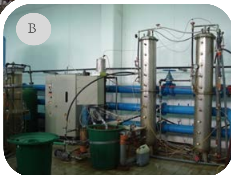
Slika 3 – A pilot-postrojenje za mikrofiltraciju; B tlačno pilot-postrojenje s pješčanim filtrima
