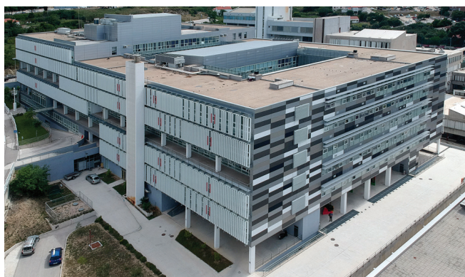
Slika 1 – Zgrada triju fakulteta: Kemijsko-tehnološki fakultet, Prirodoslovno-matematički fakultet i Pomorski fakultet u Ulici Ruđera Boškovića 35 u Splitu
