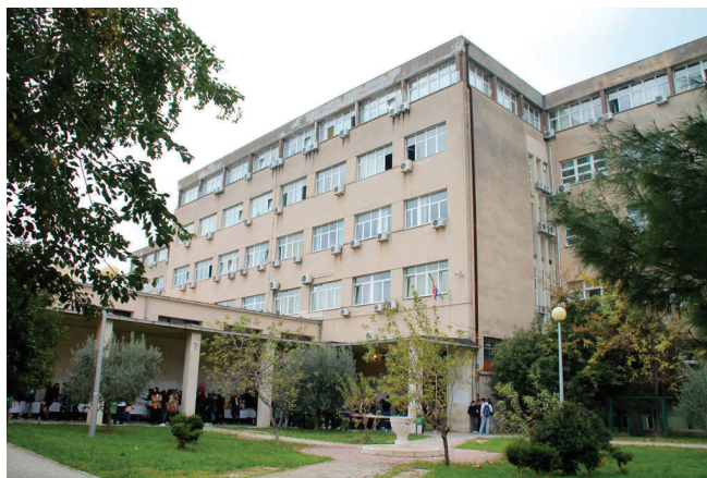
Slika 2 – Zgrada KTF-a u Teslinoj 10 (4. i 5. kat)
