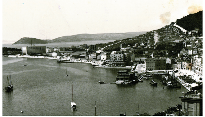
Slika 6 – Zapadna obala splitske luke neposredno prije rušenja prve dalmatinske tvornice portland-cementa (1940.) (izvor: Zbirka Muzeja grada Splita, Split)
