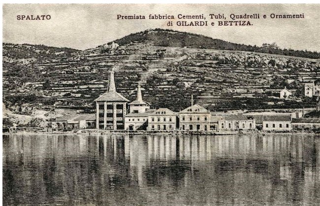
Slika 1 – Tvornica cementa Gilardi & Bettiza oko 1905. godine (izvor: Privatna zbirka Stefana Gilardija, Firenca, Italija)
