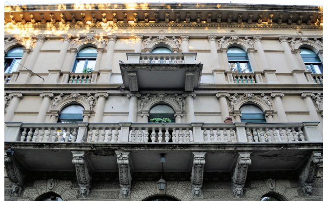
Slika 2 – Cementni dekorativni elementi Gilardi & Bettiza na fasadi vile Stock u Splitu izgrađene 1903. (izvor: Nenad Kuzmanić)
