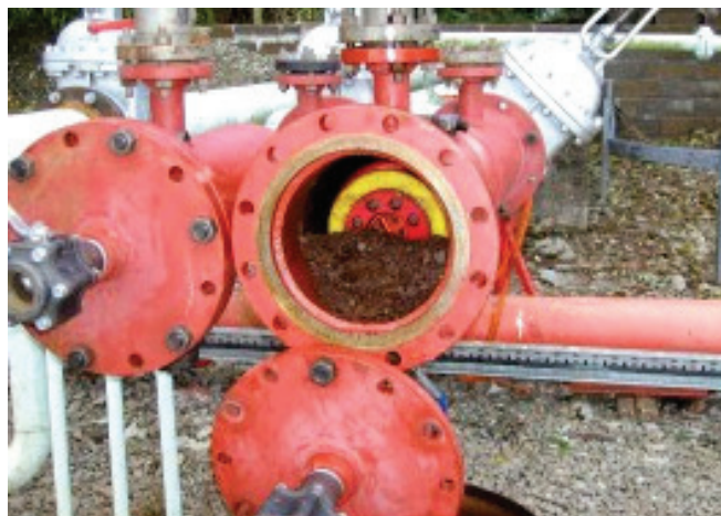
Slika 3 – Neke vrste pigova služe za čišćenje cjevovoda – na slici vidimo u dijelu cjevovoda sakupljenu hrđu. Naziv "pig" nema potpuno poznato porijeklo. Prema nekim izvorima nastao je kao kratica od eng. "Pipeline Inspection Gauge", prema drugim od eng. "Pipeline Intervention Gadget", dok je prema trećima ime dobio zbog zvuka koji stvara tijekom prolaska kroz cijev – a koji je neke podsjećao na cviljenje svinje. Pig je prisutan u svim industrijama pa i u prehrambenoj. Nemogućnost piga da ukloni 100 % u cijevima zaostalog proizvoda tjera proizvođače na ograde od toga da je u pojedinim prehrambenim proizvodima moguće pronaći tragove alergena koji nemaju veze sa samim proizvodom (izvor: www.ppsa-online.com ).
