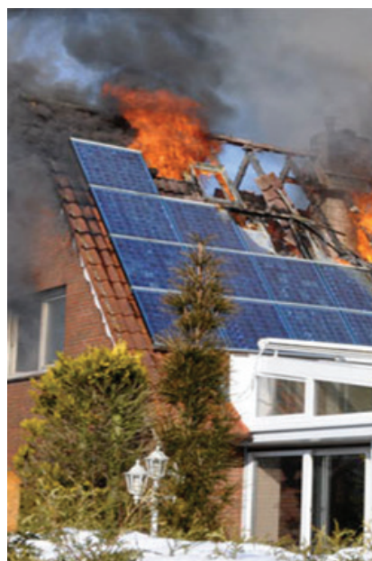
Slika 6 – Požar krovšta kuće s ugrađenim fotonaponskim sustavom (izvor: https://www.thenbs.com/ )
