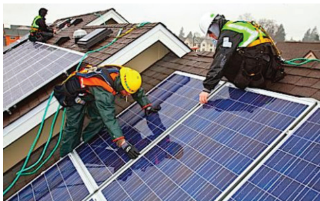
Slika 4 – Radnici na krovu objekta – ugradnja FN-panela (izvor: http://www.westseattleherald.com/ )
