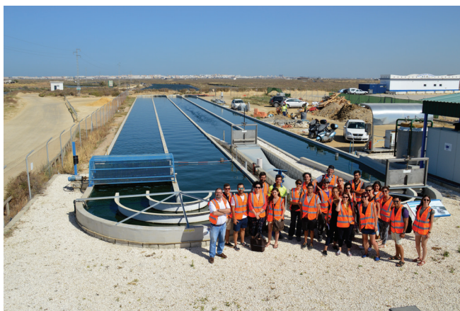
Slika 5 – Kogeneracijsko pilot-postrojenje All-Gas izgrađeno u sklopu FP7 projekta (Chiclana della Frontera, Španjolska)
