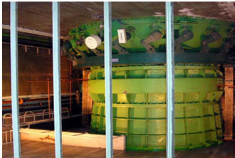
Slika 4. Generator HE Čakovec
