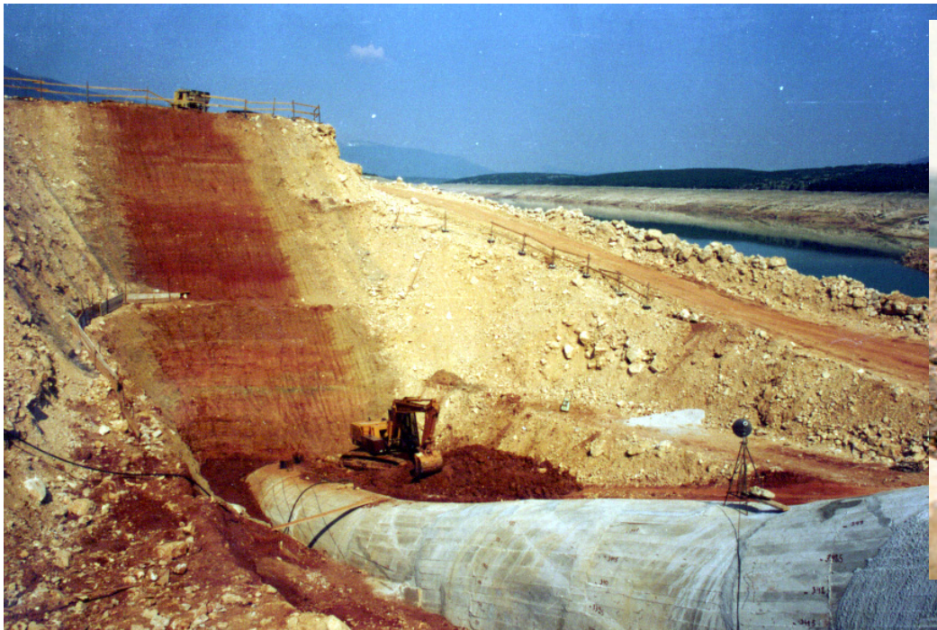
Obnova nakon miniranja brane Peruća
