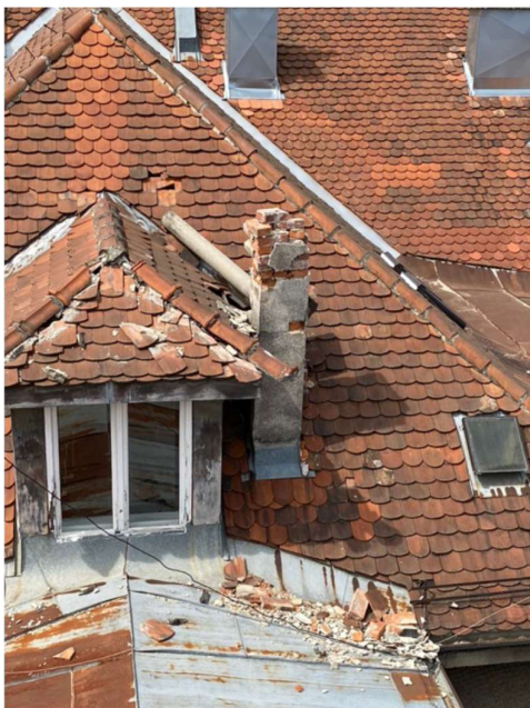
32. Oštećenja pokrova nakon potresa
