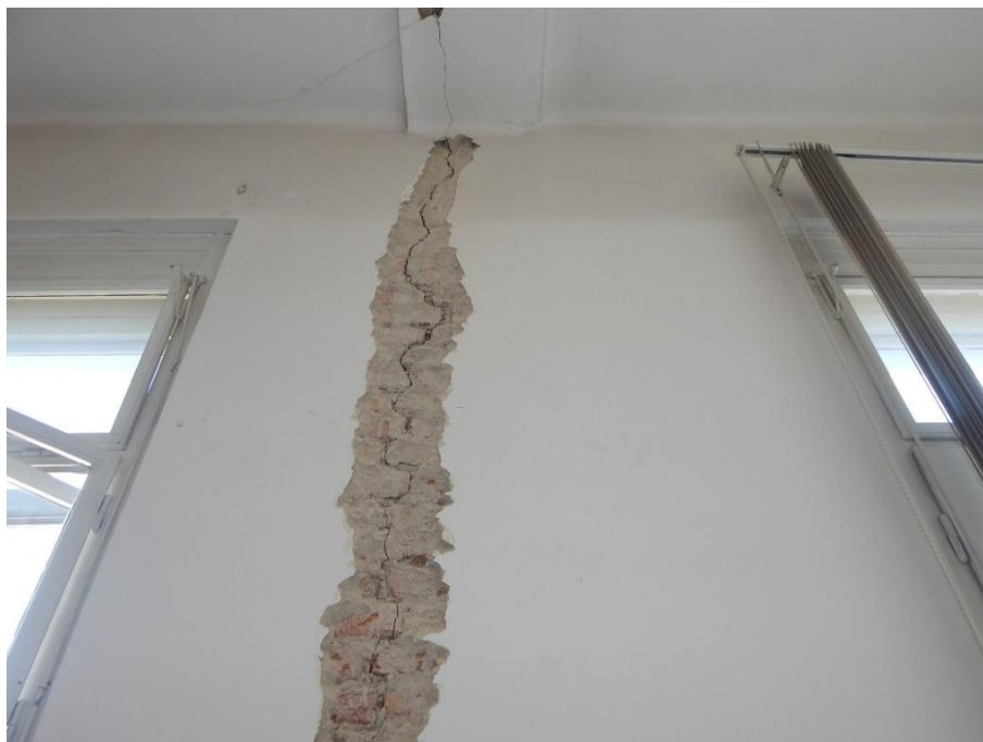
Slika 34 Pukotina u zidu na poziciji 5
