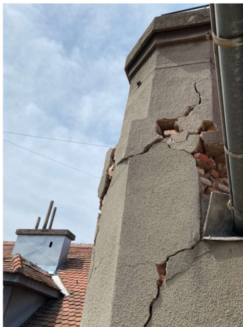
33. Oštećenja dimnjaka nakon potresa
