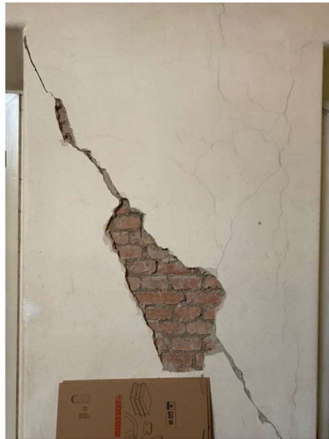
35. Oštećenja pregradnih zidova
