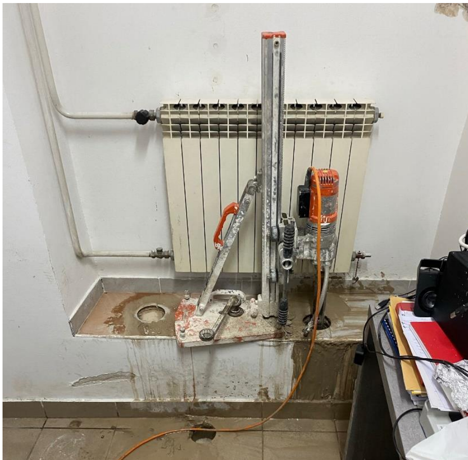
Slika 7 Bušenje temelja na poziciji 3
