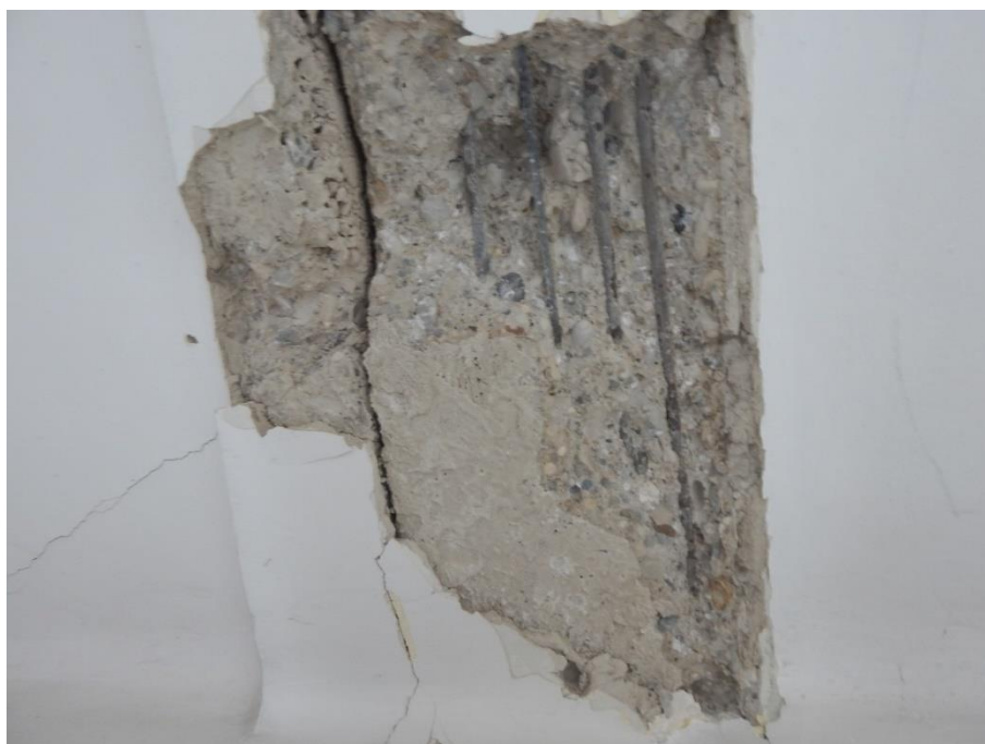
Slika 33 Detalj grede na poziciji 5
