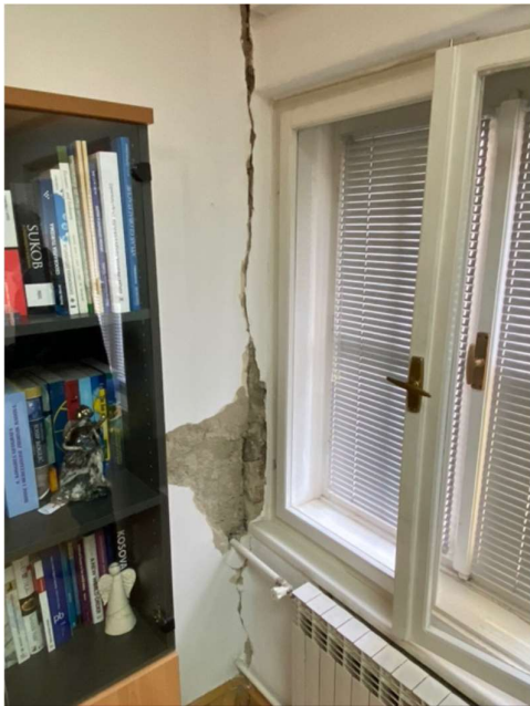
34. Pukotine na mjestima spoja konstrukcije
