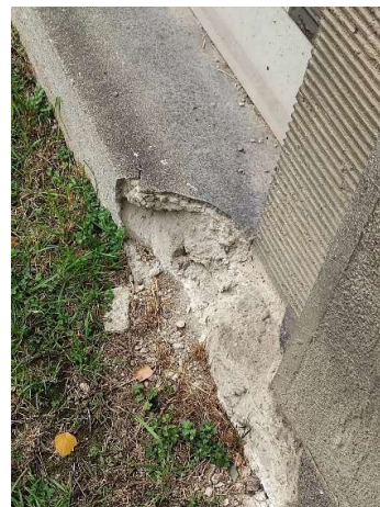
38. Oštećenja podnožja vanjskog pročelja
