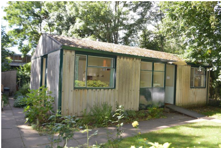
Kuća od azbestnog cementa, UK
