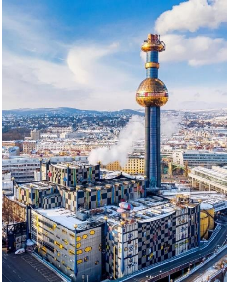
Beč (1971), 250.000 t/god, 120.000 MWh el.energ., 500.000 MWh topline
