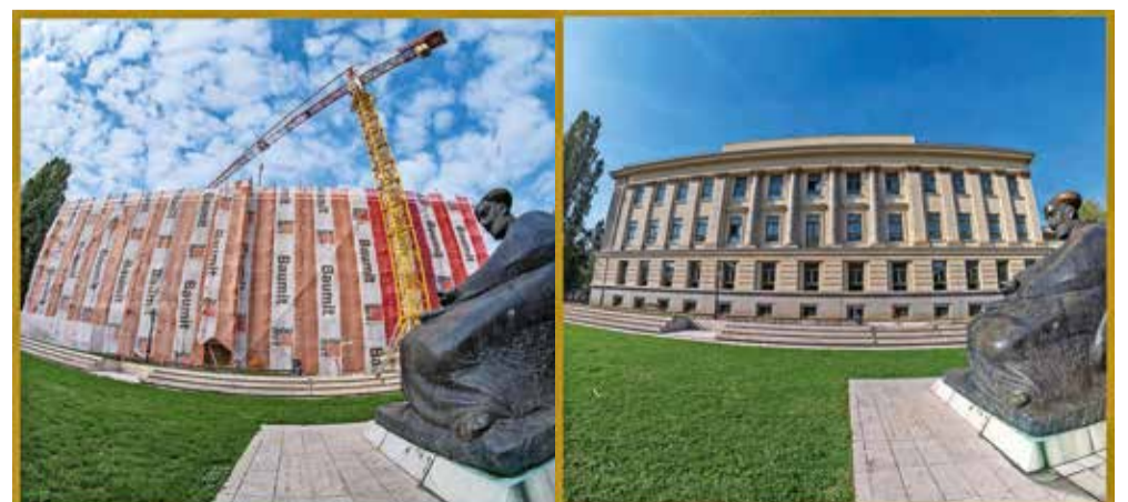
Zgrada FKIT-a na Marulićevu trgu - tijekom obnove i danas
