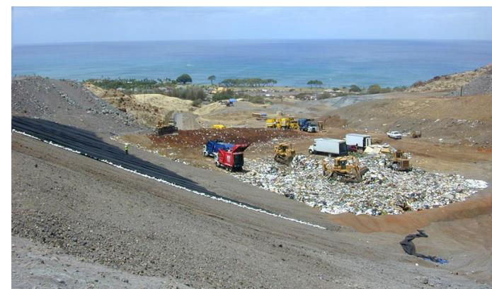
Slika 2 - Nepropusna podloga od polietilena visoke gustoće (HDPE)
