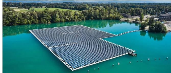
**Slika 1 –** Sustav plutajućih solarnih panela instaliranih na jezeru Maiwald, Njemačka.<sup>3</sup>
